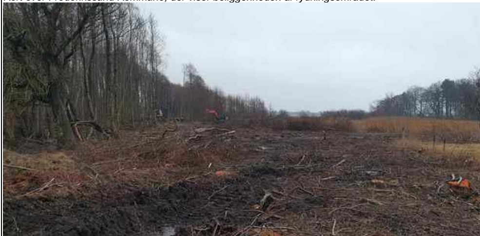
Entreprenørmaskiner er i gang med at rydde ellertræer på det fredede område. Privat foto.
