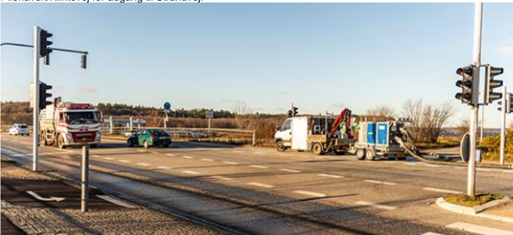
Novafos arbejder ved Strandvej og broen.
