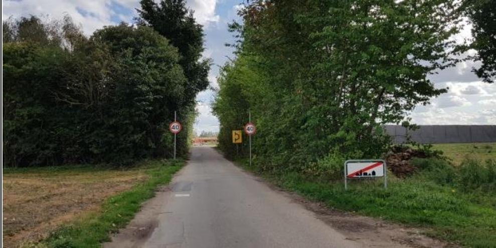
Den nuværende Marbækvej er alt for smal til at klare den kommende trafikmængde, når Fjordforbindelsen åbner. Foto: Frederikssund Kommune.
