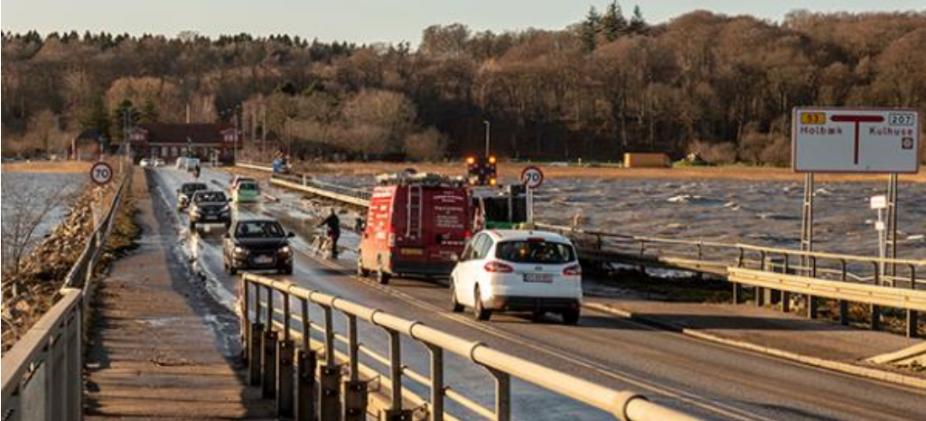
Farlig situation med krydsende cyklist på broen.
