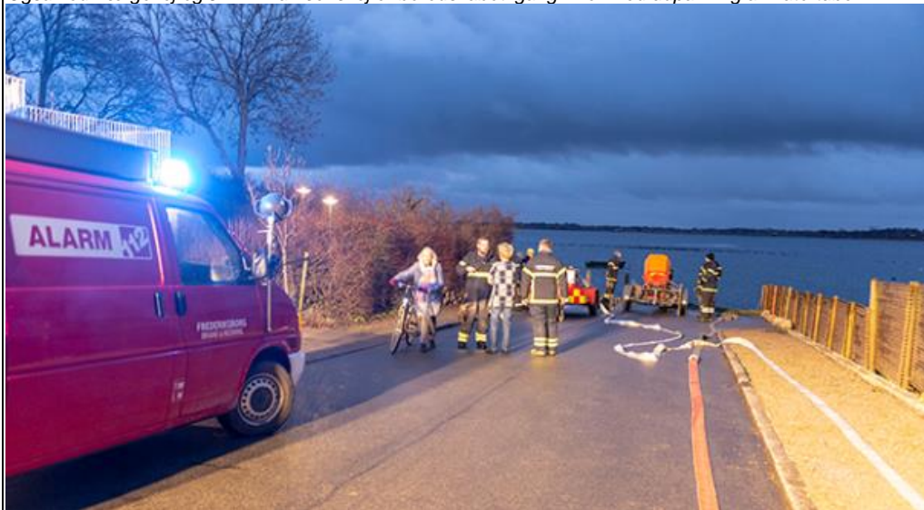
For enden af Lille Færgevej i Frederikssund pumpes vand op til fyldning af watertuben.
