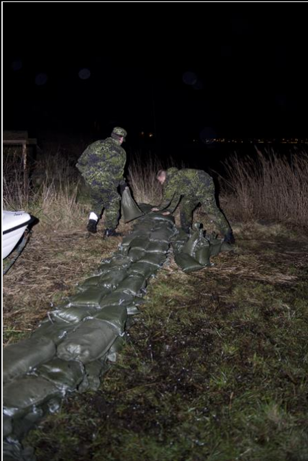
Hjemmeværnet fortsat i gang med at bygge dige ved broen.
