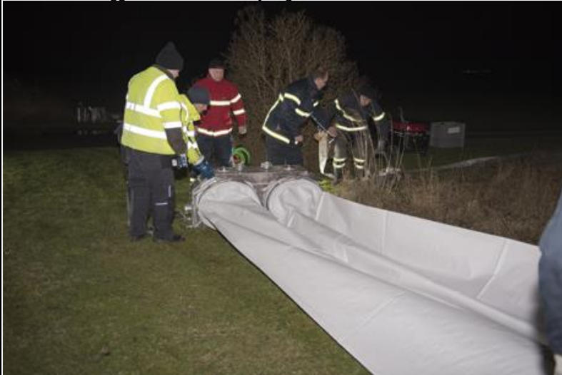
Watertuben er ved at være på plads, og der bliver fyldt vand i.
