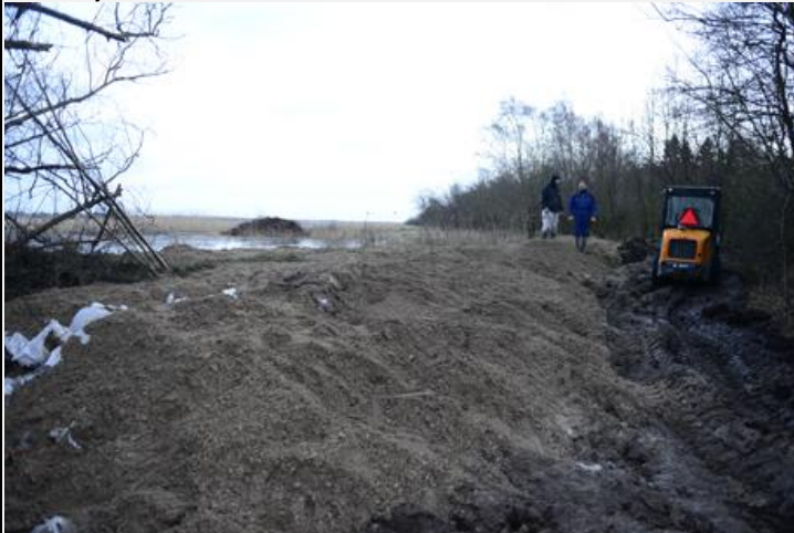
Det reparerede dige i Hyllingeris.
