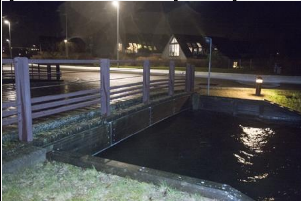
Broen over Berendsens Kanal på Stenværksvej.
