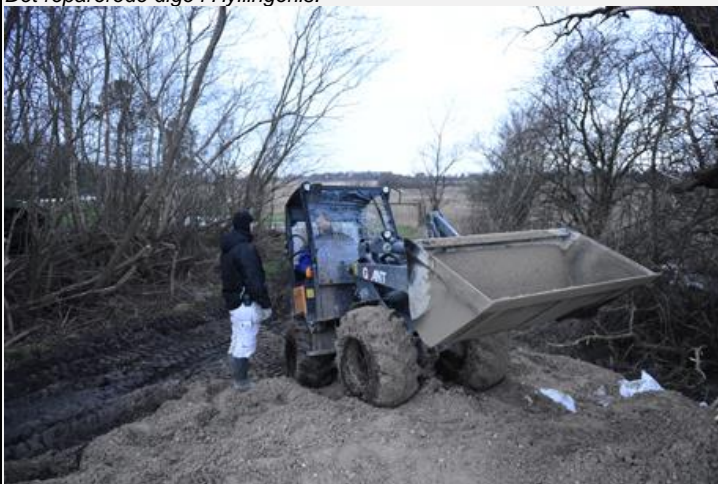
Der arbejdes med at lægge stabilgrus på diget.
