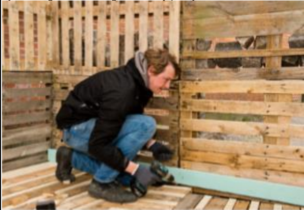
Mikkel fra Bureau Detours i gang med at bygge scene til diskoteket.
