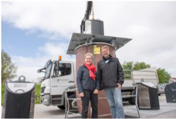
Formand for Teknisk Udvalg, Tina Tving Stauning (A), og affaldskonsulent Tom Henrik Johansen foran én af affaldsbeholderne, der er hejst op af jorden.
