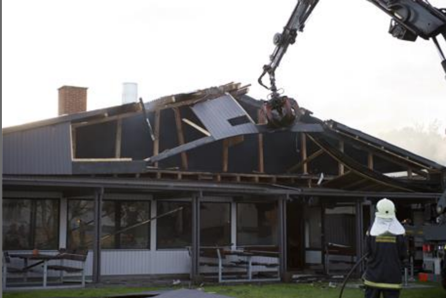
Nedrivningen af taget går i gang.
