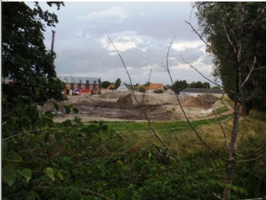
Foto fra funderingsarbejdet – når den lange pæl er hamret næsten ned, er træklodsens i hamreværktøjet banket så varm at den gløder – og ryger:
