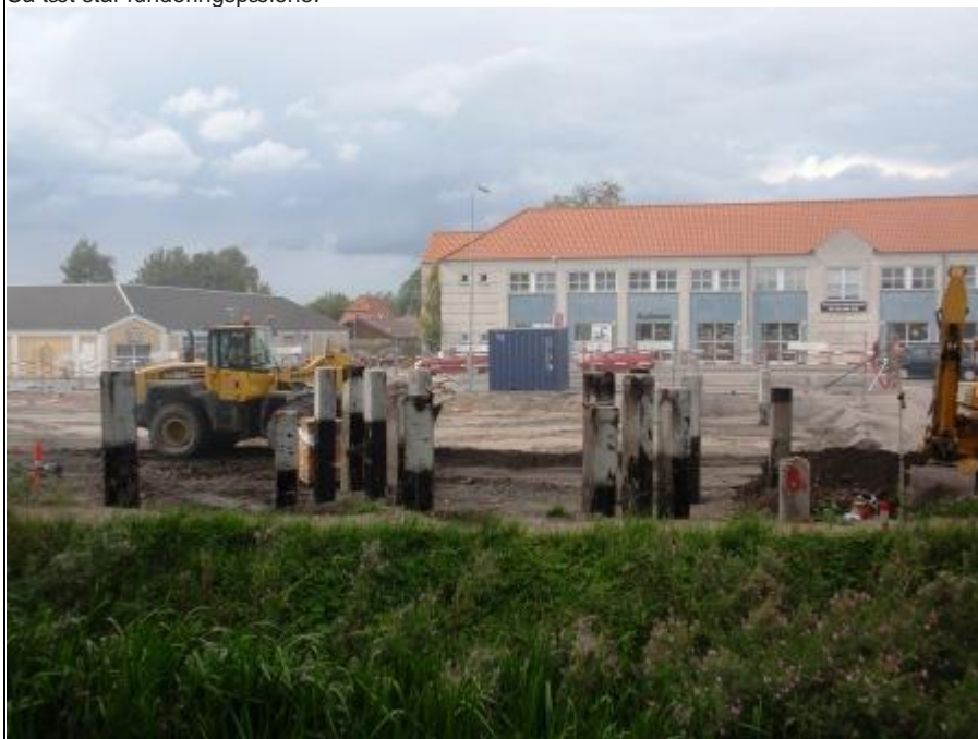
På byggepladsen flages for bygherren DK-development og entreprenøren Hornum Murer- og Entreprenørvirksomhed, HME:
