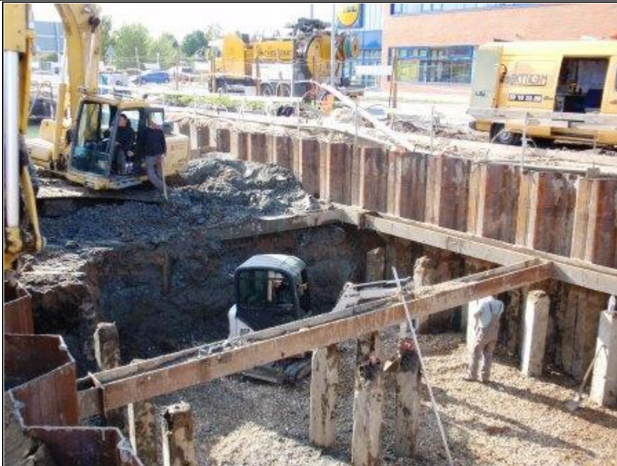
Billederne afslører et kompliceret byggeri med spuns, pilotering og højtstående grundvand. Foto: Morten Ledet
