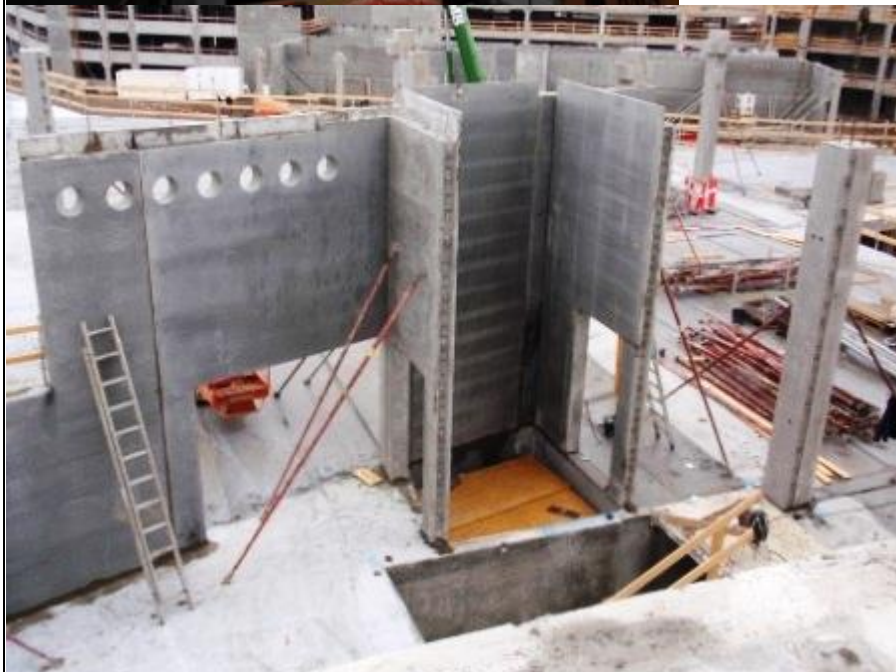
Nogle af de sidste funderingsarbejder er nu i gang. Her er en stribe fotos der viser det der snart ikke kan ses.
