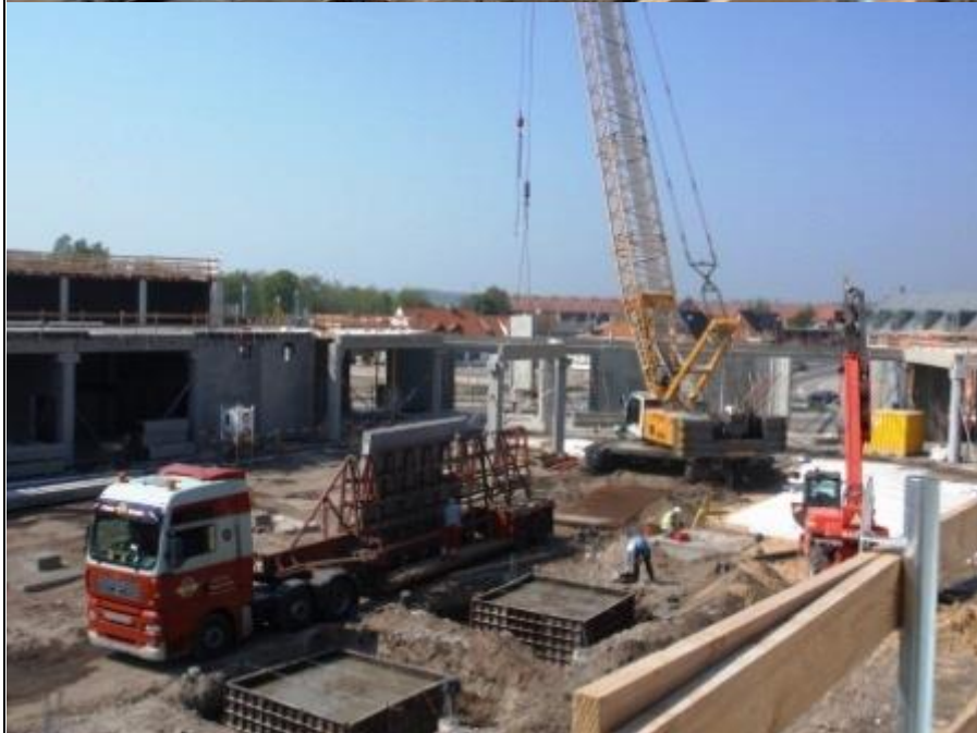
Oppe på tagene arbejdes der på (forberedelserne til) tagbelægningen.
