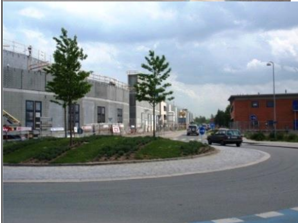
Oppe fra ser det sådan ud i det aktuelle montageområde (set fra tre forskellige vinkler).
