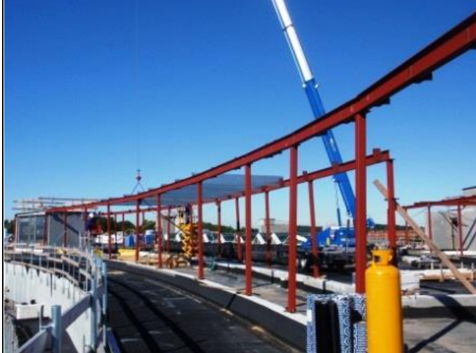
En anden markant udvikling er opstillingen af stålskelettet til centrets penthouse-lejligheder oppe på plan 3.
