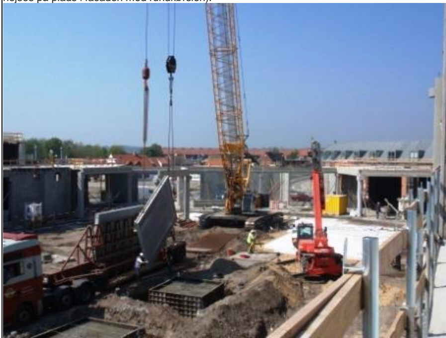
En lille serie montage-billeder taget fra et centralt punkt oppe i butiksbygningen (et element hentes fra blokvognen, tiltes og hejses på plads i facaden mod rundkørslen):
