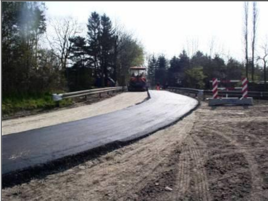
Dæmningen set oppefra fra siden - og nedefra hvor man kan se stien der fører mellem Bonderupvej og stien i banegraven. I dæmningen er indbygget ny spildevandsledning, ny vandledning, ny elkabling og ny telefonkabling.
