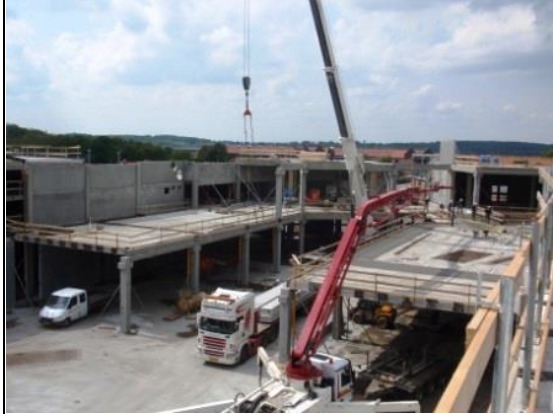
Udefra ser den igangværende montage af bygningselementer sådan ud.
