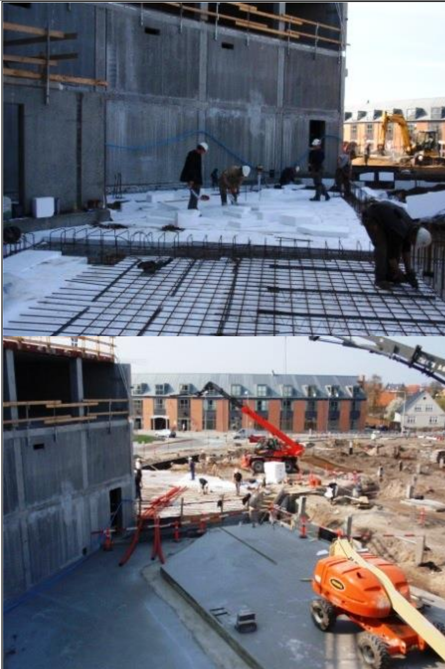
Fundamentarbejdet i rundingen mod rundkørslen skrider frem – set fra jordhøjde og oppefra.
