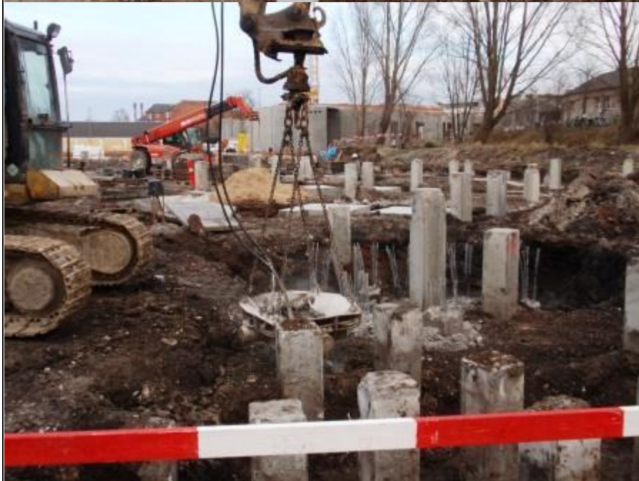
Der er stadig en del pæle der skal rammes ned...
