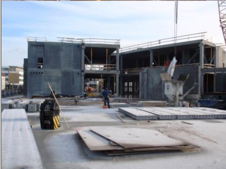
Og udsigten over Frederikssund by tog sig sådan ud set fra taget af den ny pumpestation (den nordlige spids af P-huset) som er en integreret del af centerbyggeriet.
