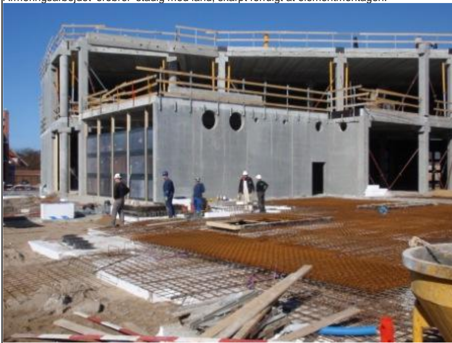
Armeringsarbejdet 'erobrer' stadig med land, skarpt forfulgt af elementmontagen.
