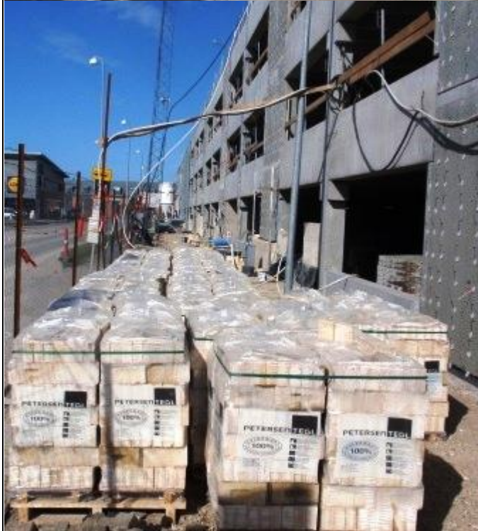
Parkeringshuset er nu på vej mod sit endelige udseende. Murerne murer kulbrændte tegl op på murpillerne, og (nedenfor) monteres gitre foran de åbne partier.
