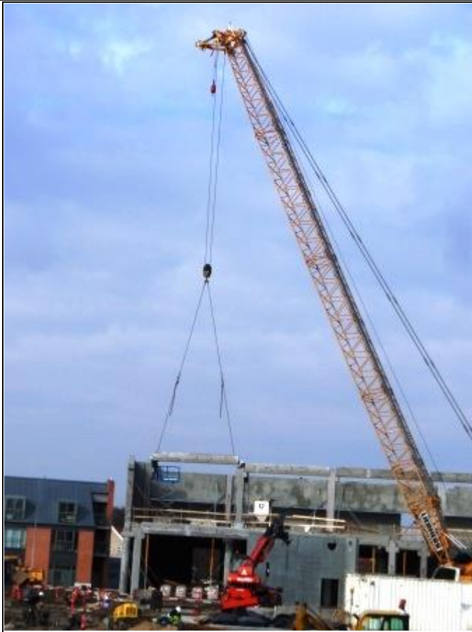
På øverste dæk gøres klar til endnu en etage med anlæg af fundament til rækken af penthouselejligheder der løber hele bebyggelsen rundt med en altanzone foran.
