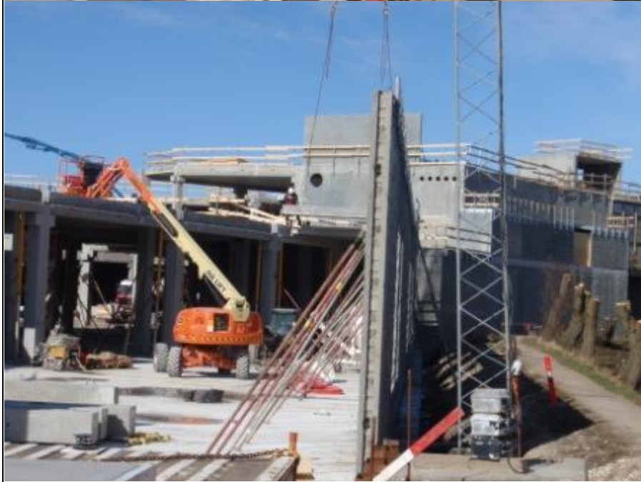
Bemærk de sikrede montører. Og de forudsete rørføringshuller.
