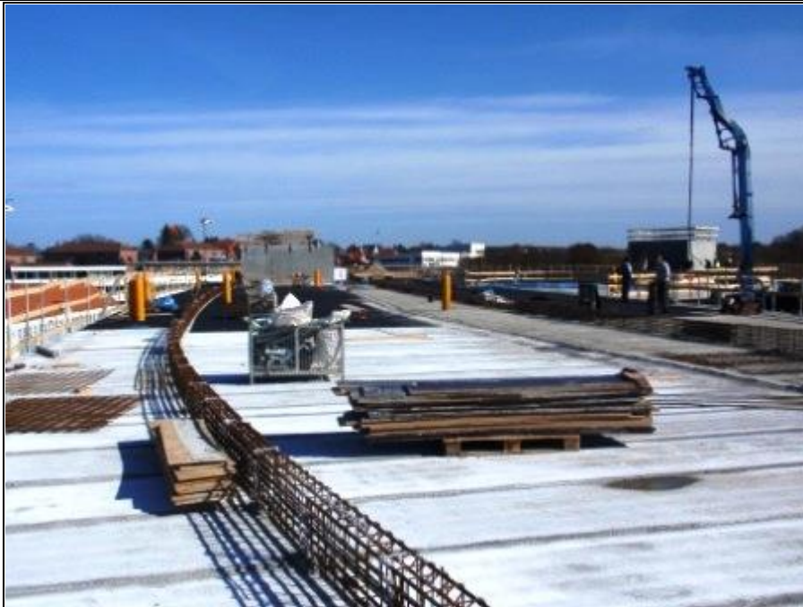
Armeringsarbejdet 'erobrer' stadig med land, skarpt forfulgt af elementmontagen.
