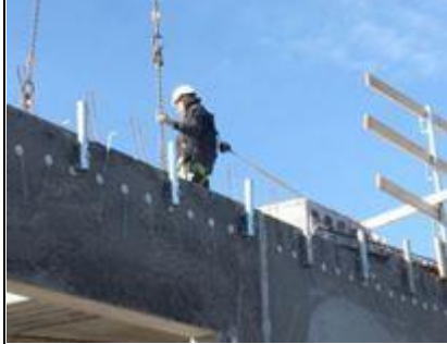
Bemærk de sikrede montører. Og de forudsete rørføringshuller.
