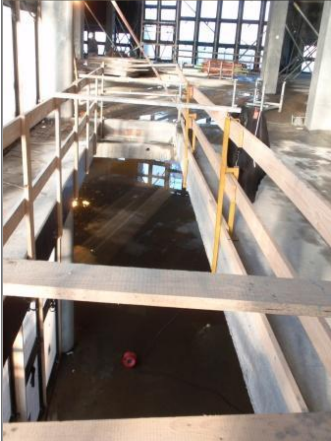
Set udefra – stående på den taget af den næste etape som endnu kun er oppe i én etage – ser den to-etager høje første etape sådan ud i tre panorama-billeder:
