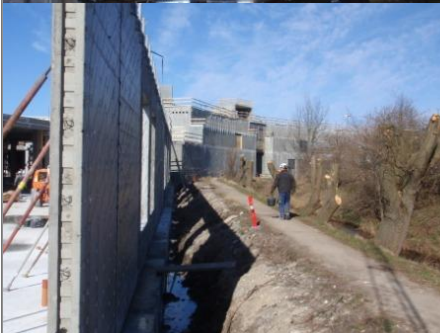
Trængsel: Inden for få minutter kan man se betonkanoner der snor sig ind og ud af byggepladsen, endnu flere pilloteringspæle og endnu flere betonelementer som efter en nøje plan føres ind på pladsen.
