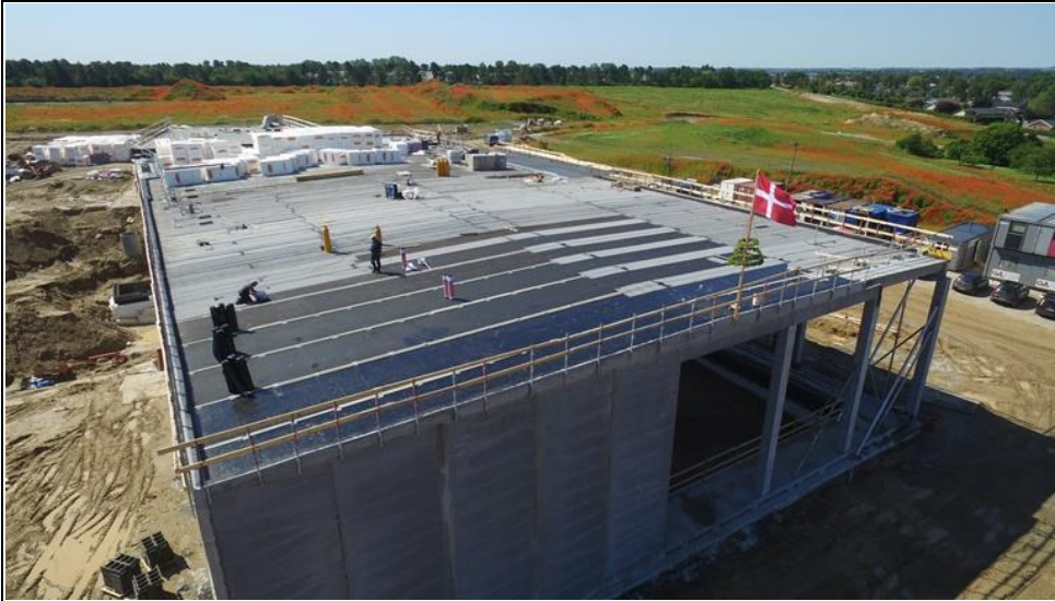
Byggeriet af den nye svømmehal set fra oven.
