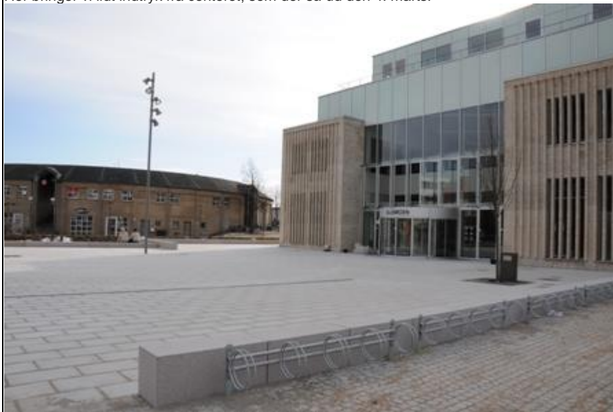
Hovedindgangen med det nye torv foran centret og stationen.
