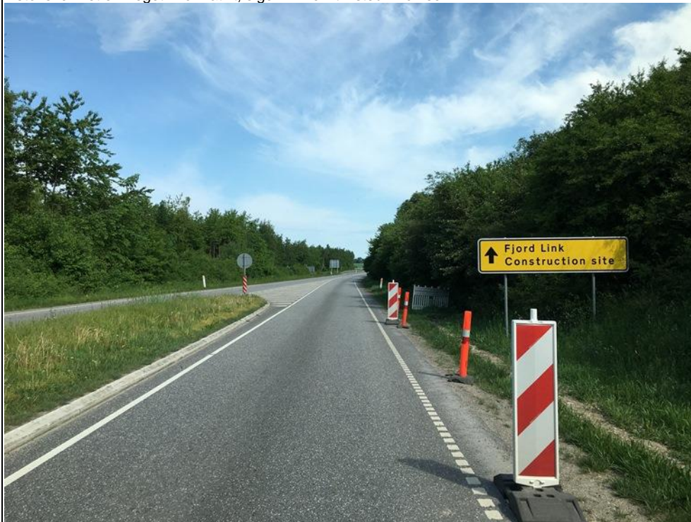
Turen gik forbi byggeriet af den nye fjordforbindelse.
