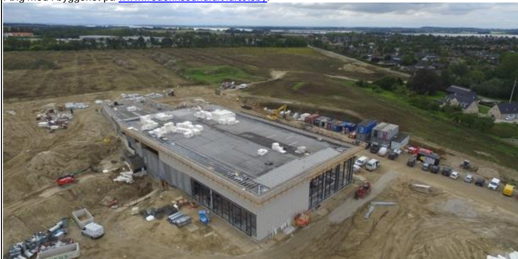
Lufffoto af svømmehalsbyggeriet fra medio september 2019. Foto: Frederikssund Kommune.
