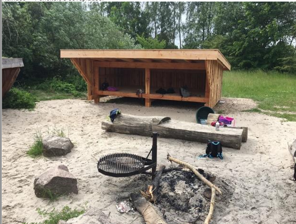
Det nye shelter med plads til 10 personer.
