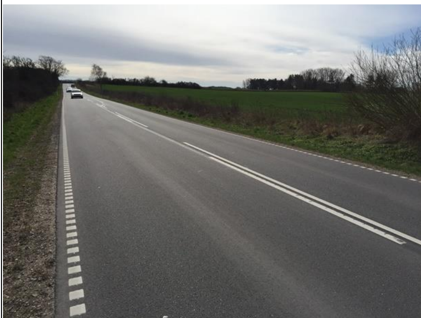
Kulhusevej levner i dag ikke megen plads til cyklister. Arbejdet med en ny cykelsti er nu i gang.
