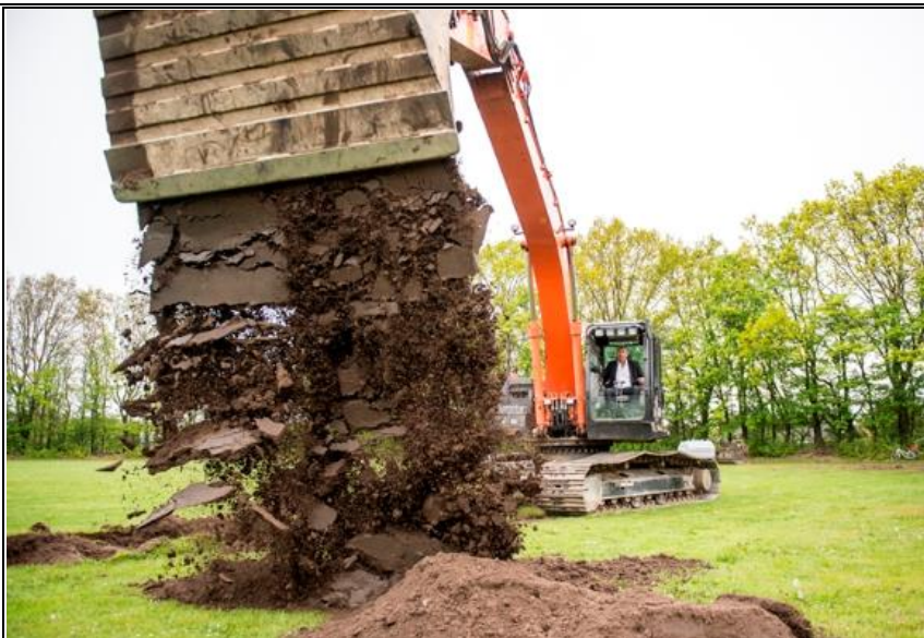
Borgmester John Schmidt Andersen tog første spadestik i gravemaskine.
