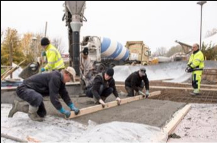
Det er præcisionsarbejde at forme og støbe en skaterbane.
