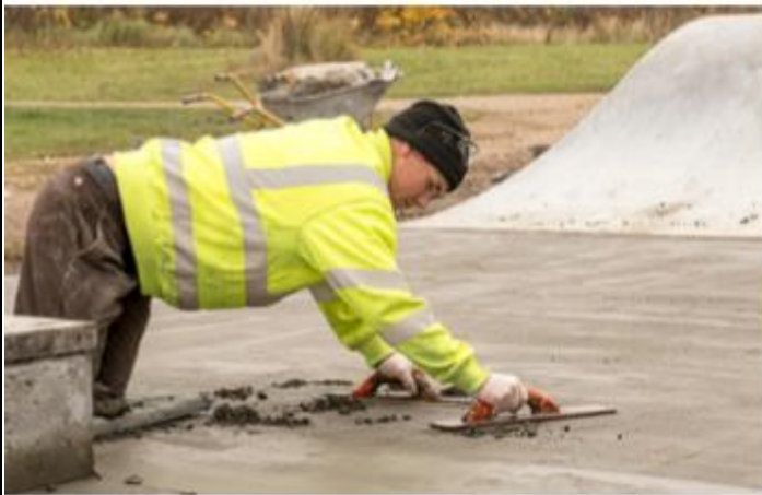
Balder Lehmann fra FSR Beton i gang med at glatte banen ud.
