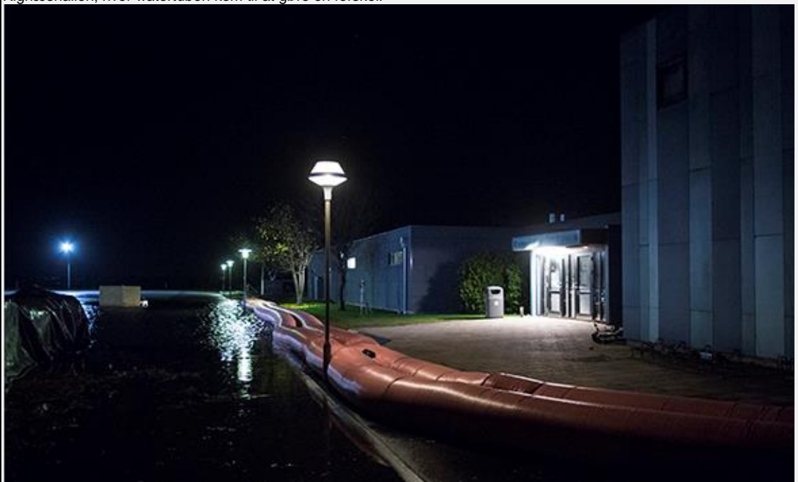
Kignæshallen er sikret med Watertube. I Hyllingeris nåede vandet slet ikke over det faste dige, og derfor heller ikke frem til watertuben - men det var tæt på ved diget, som det ses af billedet herunder fra tirsdag morgen ved solopgang.
