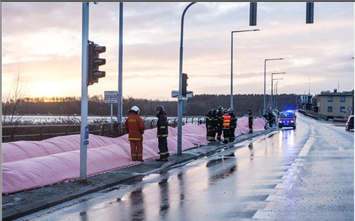
Watertubes gøres klar til at blive udlagt syd for Kronprins Frederiks Bro.
