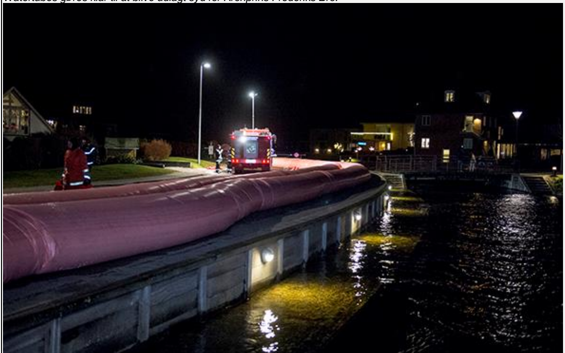
Stenværksvej og Berendsens kanal.
