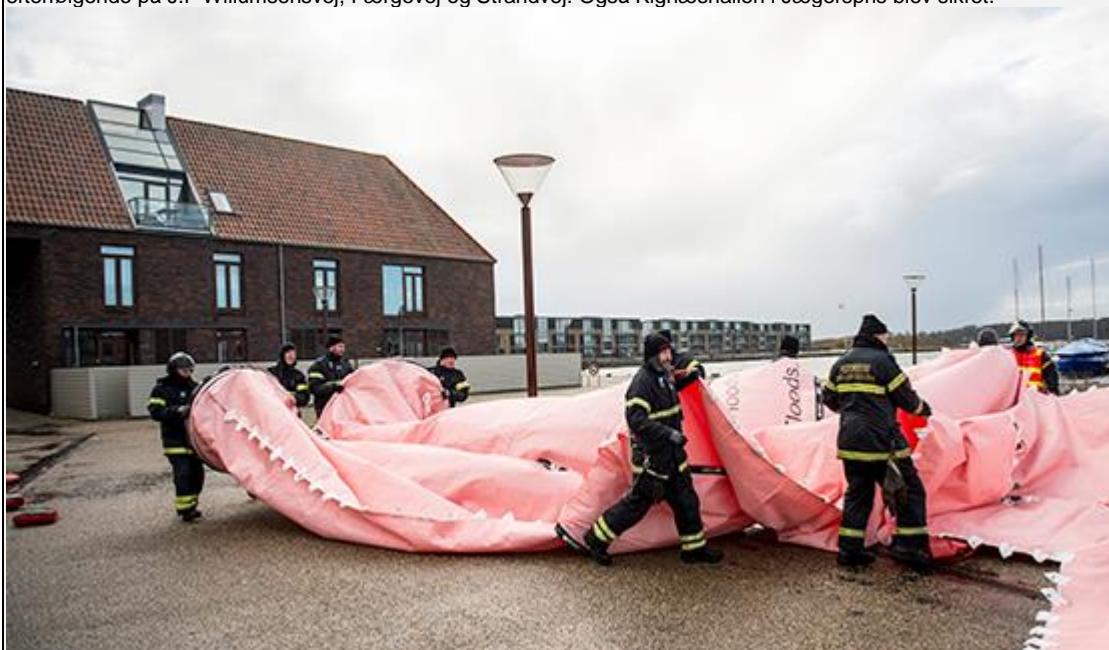
Beredskabet lægger watertube på Nordkajen i Frederikssund.
