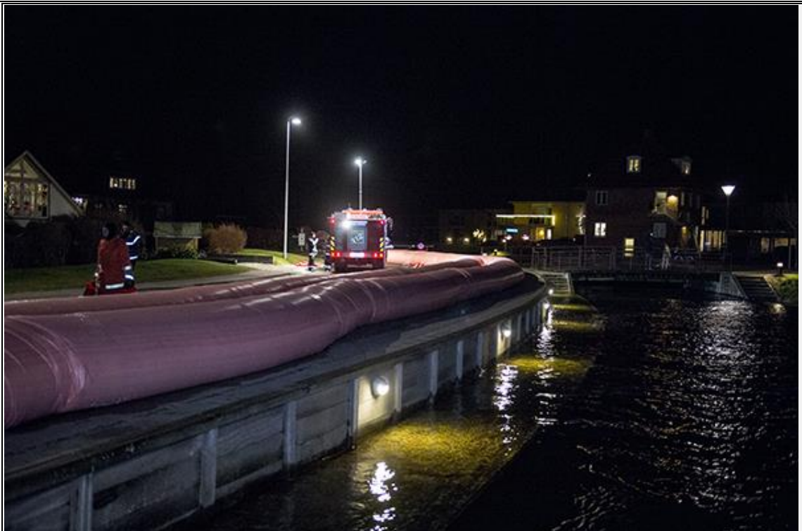
Stenværksvej og Berendsens Kanal blev mandag aften sikret med en watertube. Heldigvis nåede vandet ikke op til nogle af de udlagte watertubes. Tættest på var det på Smedeengen i Jægerspris ved Kignæshallen, hvor watertuben kom til at gøre en forskel:
