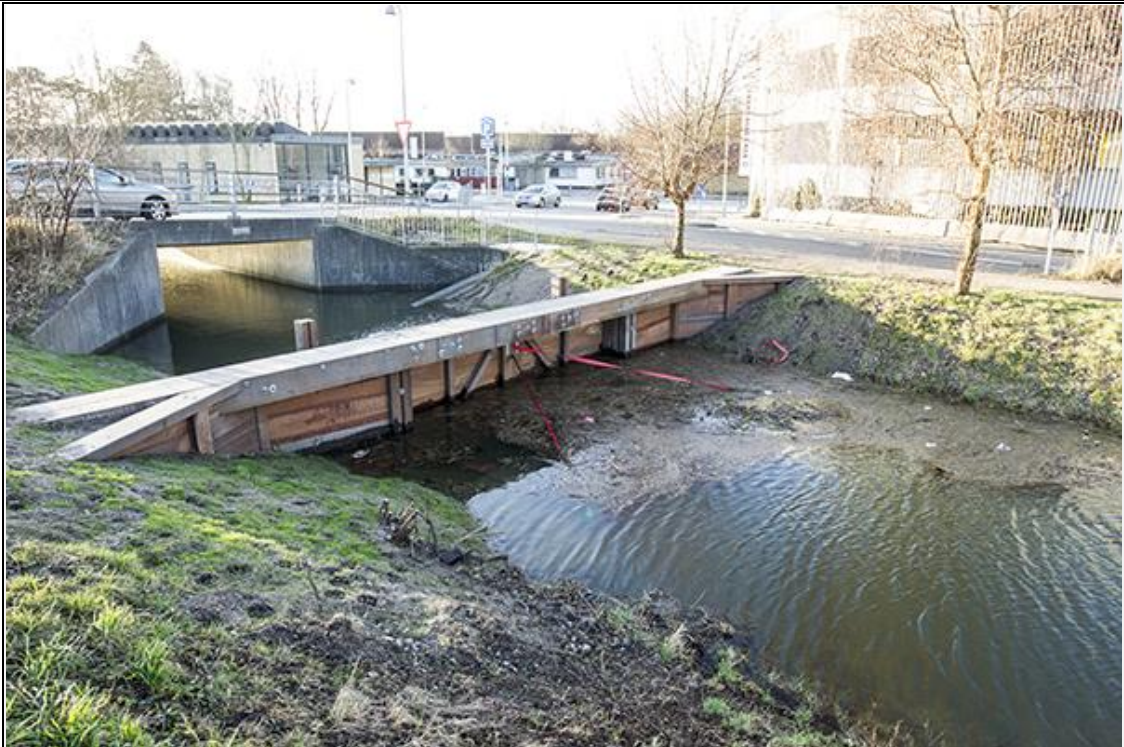
Den nye sluse ved Silkeborg.
