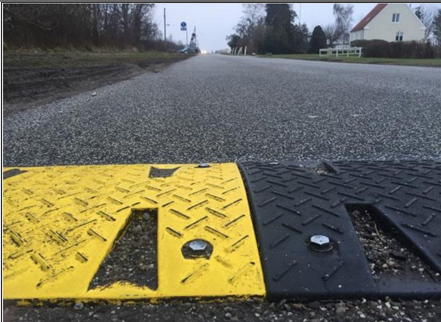
En af de fartdæmpende foranstaltninger, som borgerne har mødt på en række veje, er de klassiske bump.
