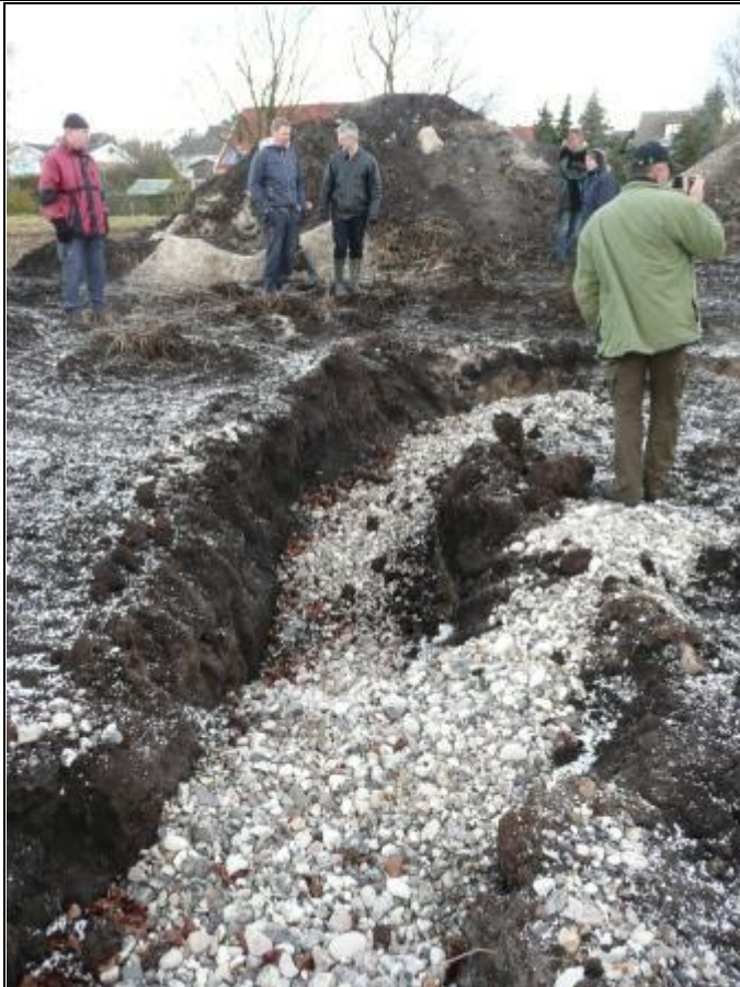
Ovenfor dele af det ny åløb med store sten, småsten og grus. Der ventes på vandet. Nedenfor to billeder af gravkograben der giver vandet adgang til det nye åløb. Og dernæst vandet der trænger længere og længere ned ad det ny forløb.
