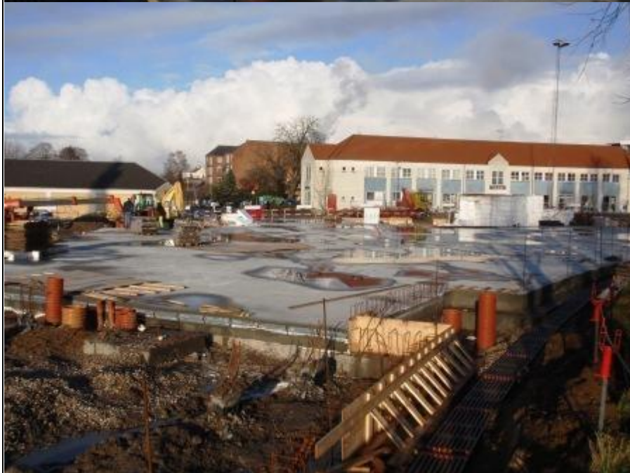
Længere inde på grunden fortsætter pilloteringen, og pælene står stadig lige tæt. Nogle pæle kan komme langt ned, andre knap så langt. De lange 'strittere' er pæle nummer to der er lasket oven på pæle der er banket helt ned.
