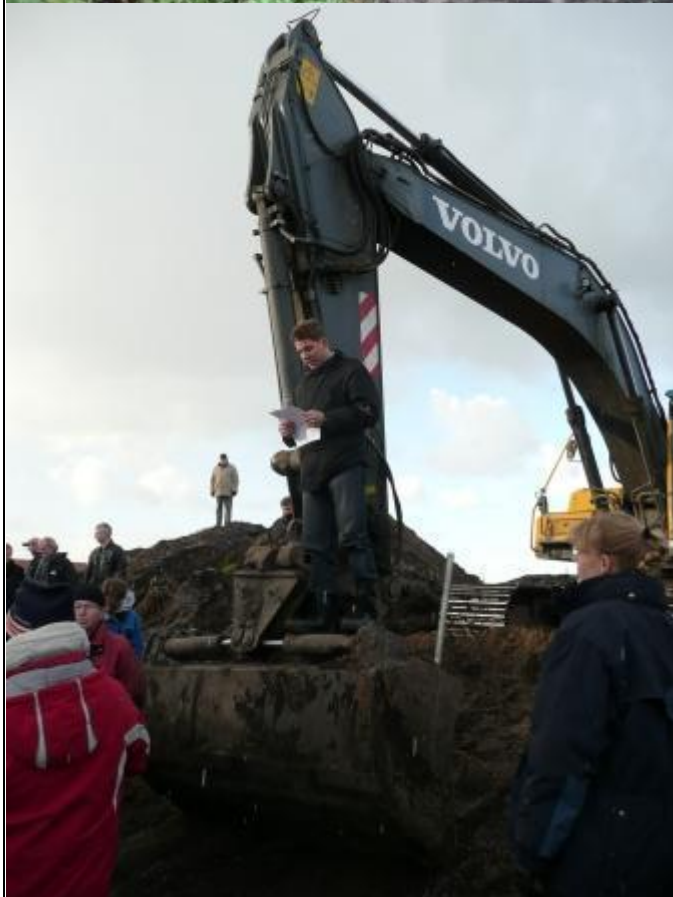
Morten Skovgaard, formand for Teknik- og Miljøudvalget, taler ved åbningen for vandet til det ny åløb – inden han griber styrepindene og tager det 'sidste spadestik'.
