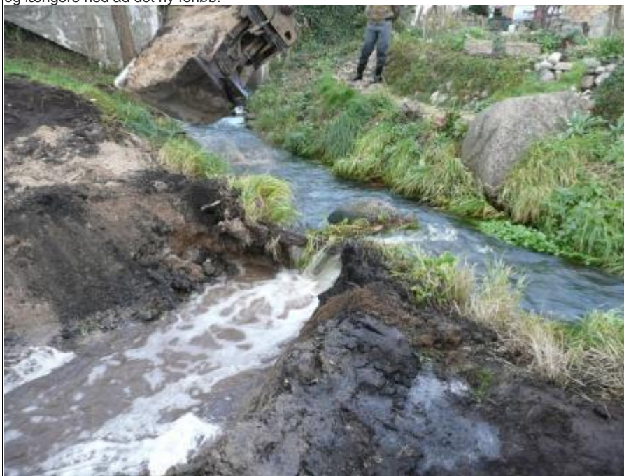
Ovenfor dele af det ny åløb med store sten, småsten og grus. Der ventes på vandet. Nedenfor to billeder af gravkograben der giver vandet adgang til det nye åløb. Og dernæst vandet der trænger længere og længere ned ad det ny forløb.
