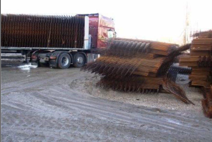
Under stationscentret bygges en kloakpumpestation, og det er en lang og indviklet byggeproces som det måske fremgår af billederne:
