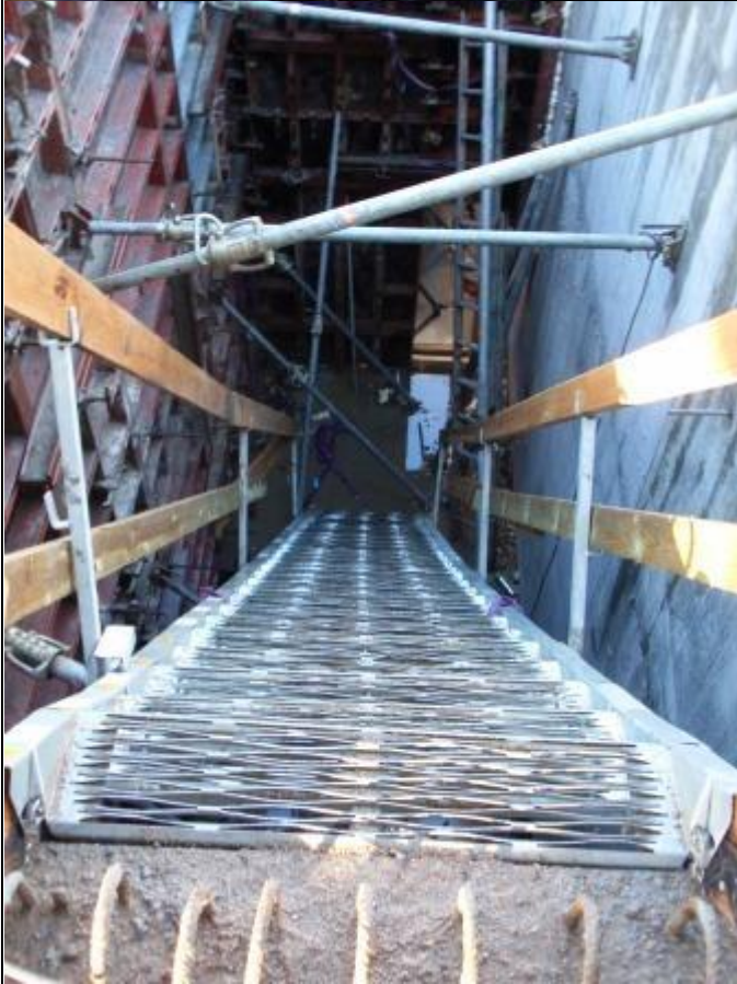
For at man kan komme rundt på byggepladsen uden at synke dybt i mudderet er der lagt læssevis af småsten på kørevejene, og de gående har fået udlagt stier fra trætraller (som her langs diget mod Sillebro Å):
