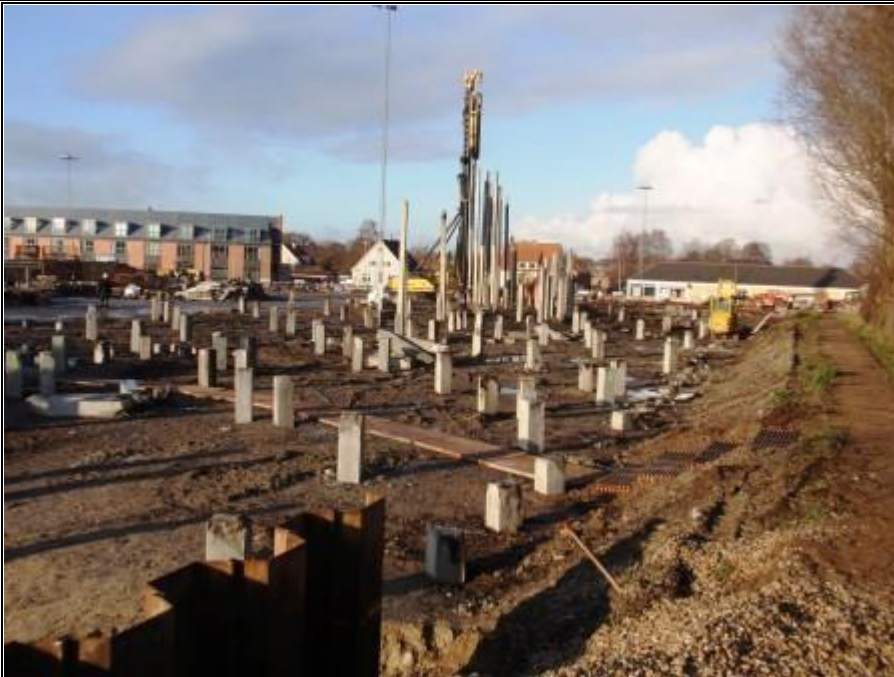
Armeringsjern til indstøbning i det næste stykke betondæk ligger allerede i store stakke, og der køres stadig mere til.
