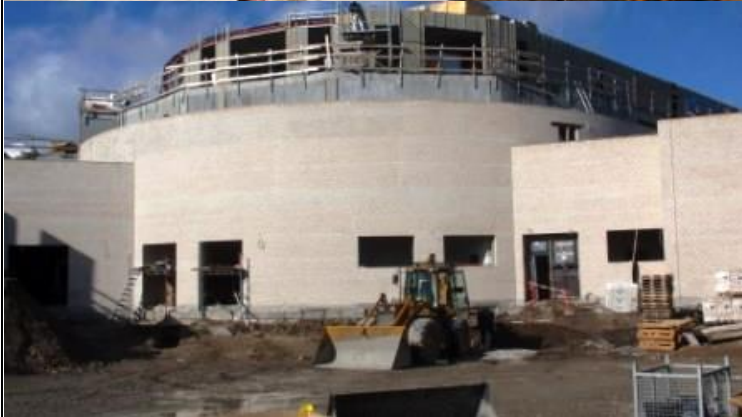
Facaden mod Sillebro Å ses her først fra altanzonen på penthouse-etagen, dernæst fra 2. etage hvor der bliver en terrasse, og endelig nede fra digekronen hvor der bliver genetableret en sti (promenade) når facadearbejdet er færdigt.
