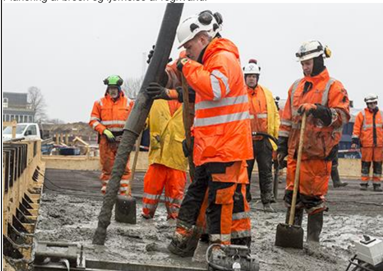
Broarbejdere fylder beton på broen.
