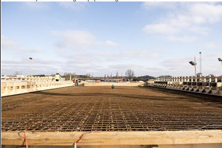
Broen er klar til støbning.
