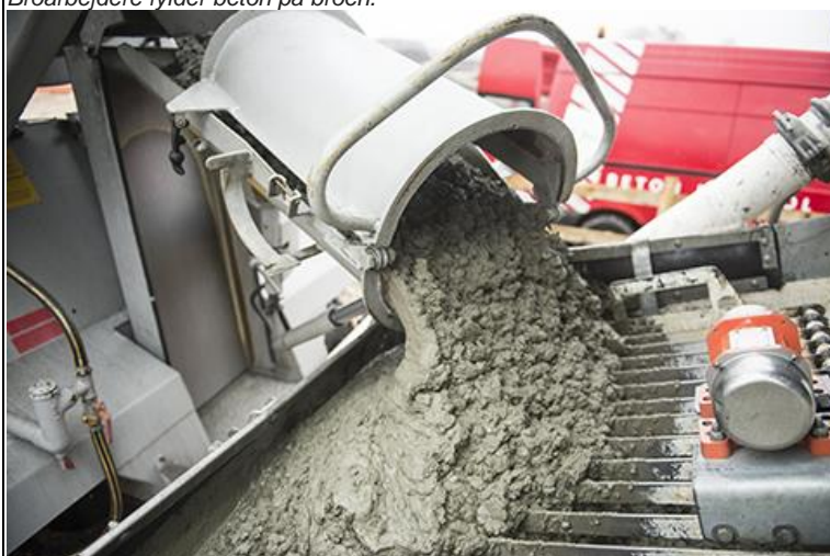
Fyldning af betonkanon.
