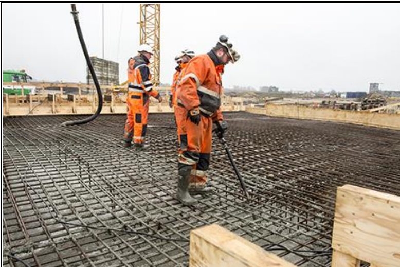
Brobyggere i gang med støbningen.
