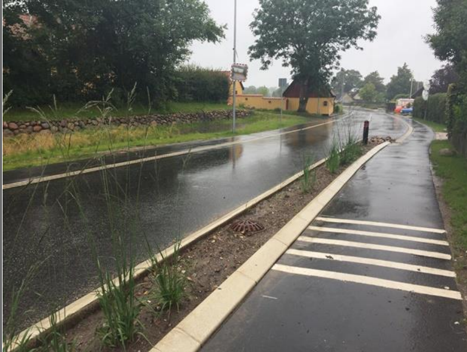
Regnvandsafledning på vej i Græse.
