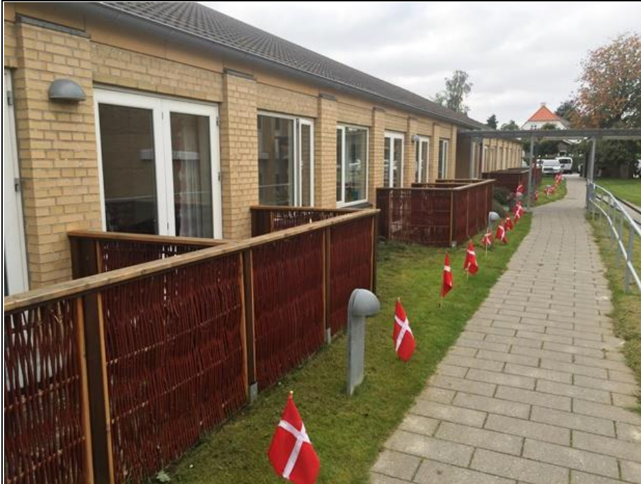
De 16 nyrenoverede handicapvenlige boliger har også egen lille terrasse.
