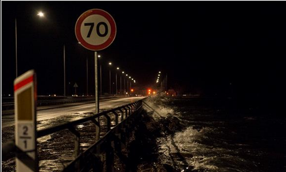
Forhøjet vandstand ved Kronprins Frederiks Bro i december 2016.
