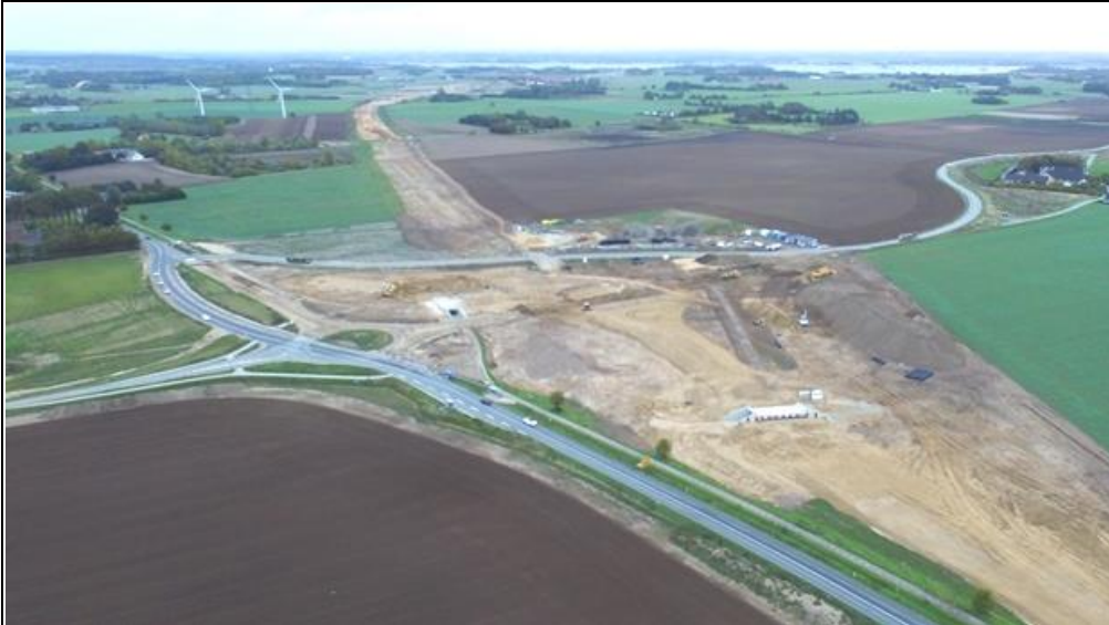
Anlægsarbejdet til den nye firesporede motortrafikvej, som skal binde rute 53 sammen med rute 211, er godt i gang. Her ses hvor vejen skal tilsluttes rute 53 lige syd for Lyngerup i Hornsherred. Vejen får navnet Fjordlandsvej. Foto: Steven Rønnenkamp Holst, Frederikssund Kommune.
