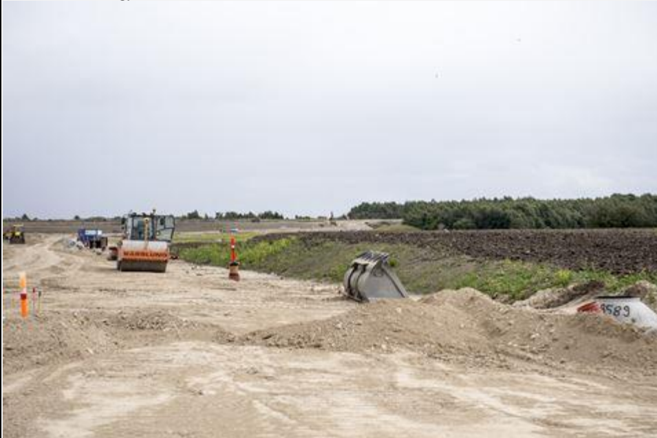
Vejen begynder så småt at tage form. I baggrunden ses Frederikssundsvej, som ligger en del højere end det øvrige terræn. Derfor er det nødvendigt at tilføre omkring 75.000 m 3 jord for at udligne niveauerne. Fotos: Kenneth Jensen.
