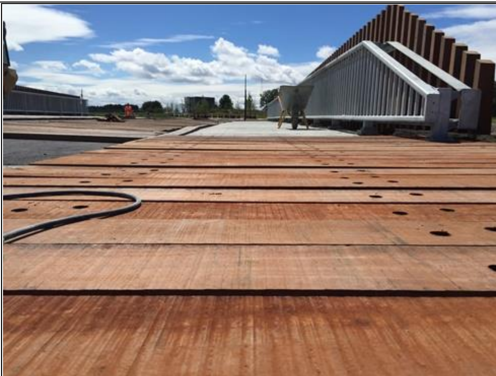
Deltabroens fortove får belægning i hårdt træ i begge sider af broen.
