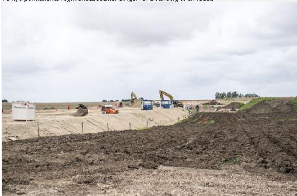
Terrænet bliver tilpasset vejen og ikke omvendt. Nogle steder skal niveauet hæves, og andre steder skal der fjernes jord, for at vejen kan få et lige forløb.
