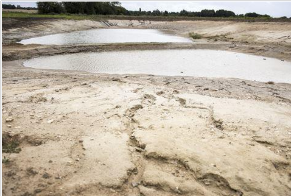
To nye permanente regnvandsbassiner sørger for afvanding af området.
