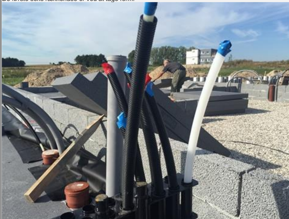
I bunden bliver der lagt isolering -
