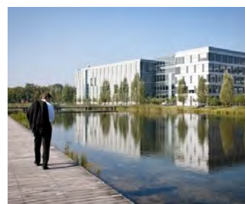
Grønt campus byggeri Eindhoven, Holland
