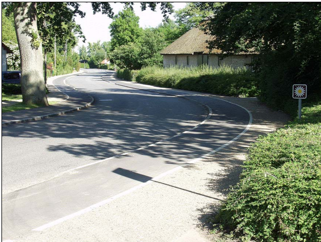
Sikring af skolevej på Selsøvej
