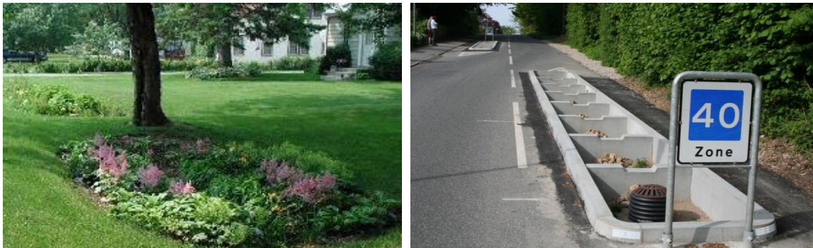
Figur 14-5. Tv. ses et eksempel på et regnbed og th. ses en nylig installeret vejkantsbed i Vejle, billedet er venligst udlånt af Wavin.
