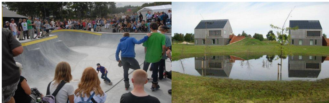
Figur 14-6. Tv. ses en skaterbane der fungerer som tørbassin ved kraftige regnhændelser. Th. ses et vådbassin/Dam.
